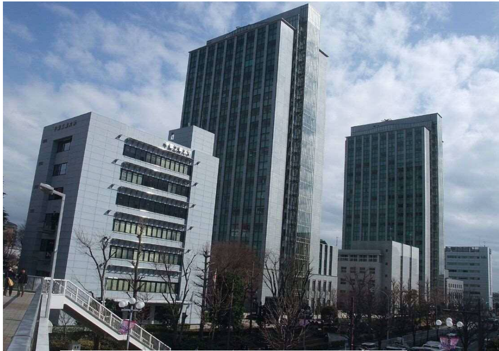
津田沼校舎 JR津田沼駅前歩道橋より
