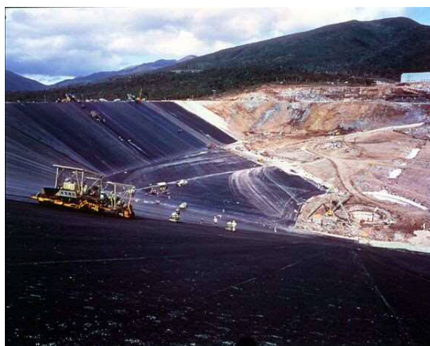
写真一1 施工状況例
