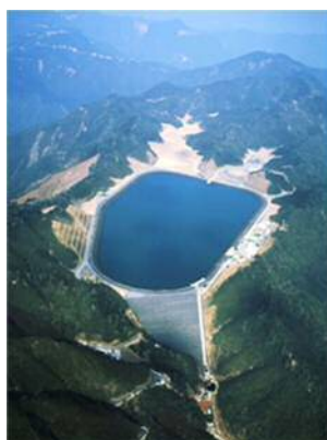
写真一3 小丸川発電所 上部調整池
