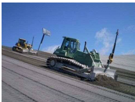
写真一2 3D-MCによる トランジション施工
